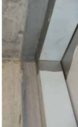
Joint EI 90 avec éléments pour joints Intumex AS (École supérieure de Saint Gall)
