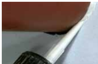
D'abord remplir l'espace annulaire avec Intumex AN
