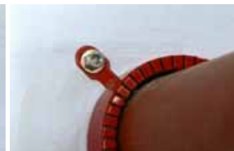
Ensuite mettre la manchette coupe-feu autour le tube et la fixer dans le fond avec des vis appropriées
